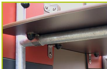
3- **Les planchers** sont usinés dans des panneaux compact structurés et antidérapants et ont une épaisseur de 12,5 mm. Ils sont renforcés par un châssis composé de tubes en acier galvanisé.
