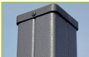
2- **Les poteaux carrés 95 x 95 mm** sont en acier galvanisé peint, garantissant la longévité et la robustesse dans le temps. Ils sont recouverts d'un chapeau en polyamide chargé qui est riveté sur le poteau.
