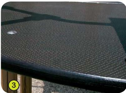
3- **Les planchers** sont usinés dans des panneaux de contreplaqué de 22 mm composés de plis minces en bouleau et recouverts en surface d'un film de résine phénolique antidérapante.
