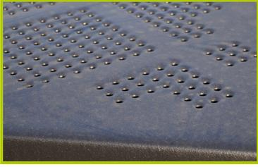
**8- Les planchers et les marches** sont en tôle acier, épaisseur 2 mm, recouvert de PVC.
