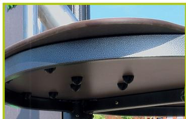
3- **Les planchers** sont usinés dans des panneaux compact structurés et antidérapants et ont une épaisseur de 12,5 mm. Ils sont renforcés par un châssis composé de tubes en acier galvanisé peint.
