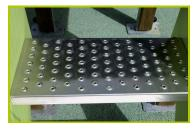
**5- Les marches de l'escalier** sont en tôle d'aluminium larmé plié assurant la robustesse et la longévité de l'ensemble.
