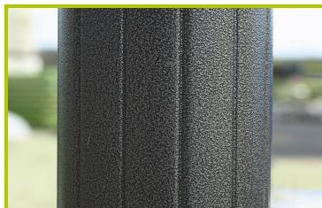
2- **Les poteaux** d'un diamètre de 125 mm sont en acier galvanisé laqué. La finition granitée en deux tons de gris présente de légers reliefs et confère une meilleure résistance aux rayures.
