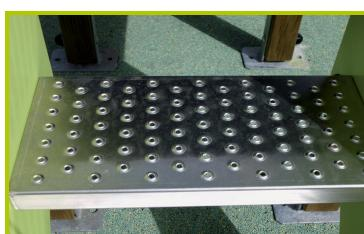
5- **Les marches de l'escalier** sont en tôle d'aluminium larmé plié assurant la robustesse et la longévité de l'ensemble.
